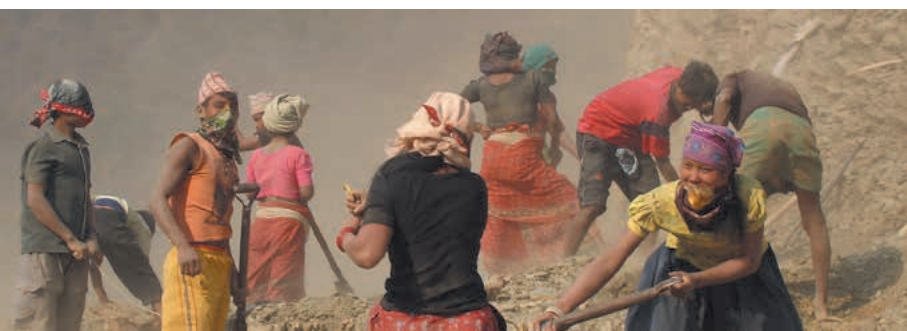
Programme Labour-based road construction (DRSP) de la DDC au Népal. Grâce à une gestion programmatique sensible au conflit, le travail a pu être poursuivi pendant le conflit armé.
