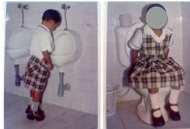
Inadecuada altura de instalación de aparatos sanitarios
