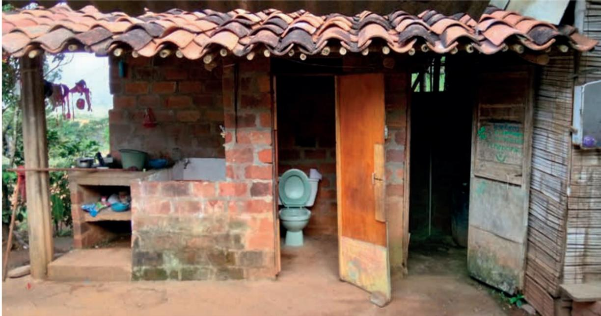
**Lavadero.** En las experiencias reconocidas en campo, el lavadero incluye cubierta para la protección del sol y la lluvia. Se destaca la propuesta de visual al frente, amplio almacenamiento y área de losa, dado que estos son utilizados como tanque de almacenamiento ante la escasez.
