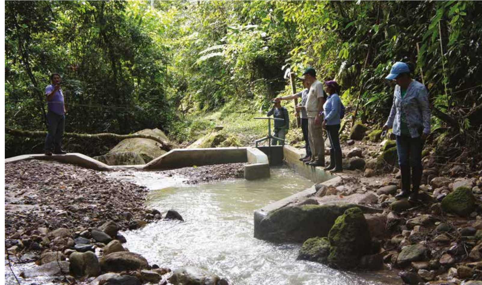
▲ Recolección de datos en obra de captación de agua, Moyobamba, Perú.
